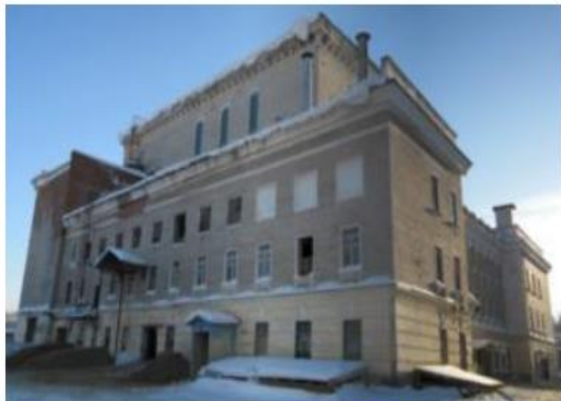
Внешний вид здания ПУГР ЭИ-2 до начала работ по ВЭ 2012 г.
