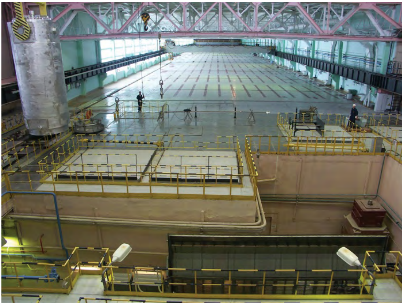
Рис. 12 Общий вид мокрого хранилища ОЯТ (ХОТ-1)
