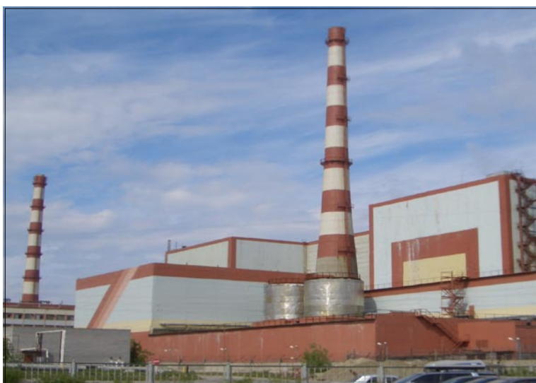
Кольская атомная станция
